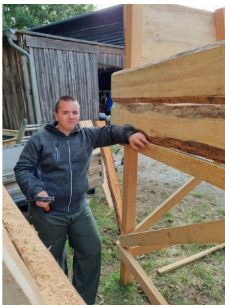
2-3. ábra: Lőállás készítés, ezeken a képeken már az oldalfalat helyeztük fel.
