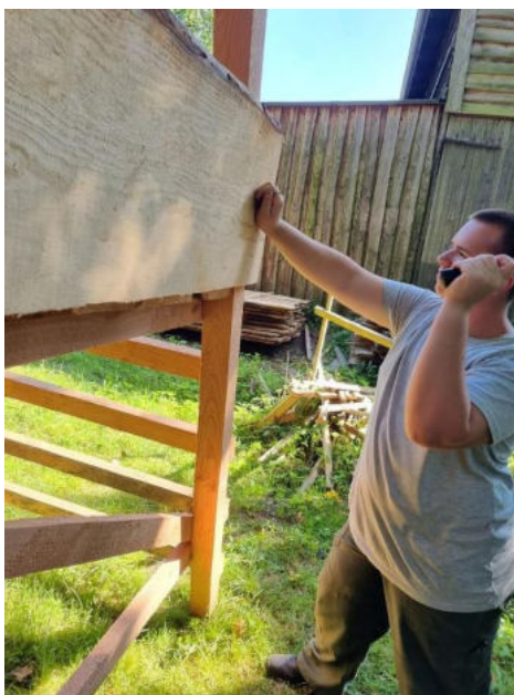
2-3. ábra: Lőállás készítés, ezeken a képeken már az oldalfalat helyeztük fel.
